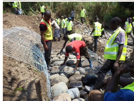
河道を修正する工事の様子
